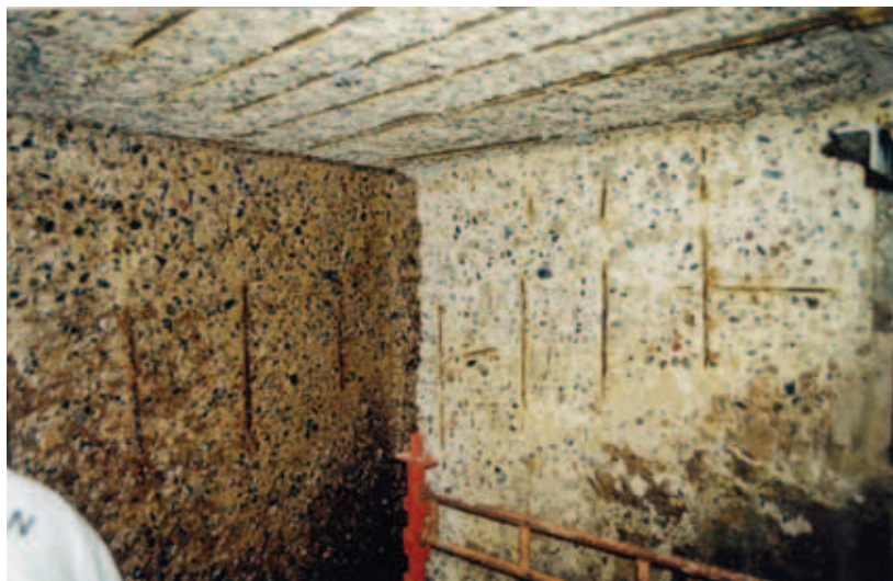
Pumpgrop – renoverad och ytskyddad.
