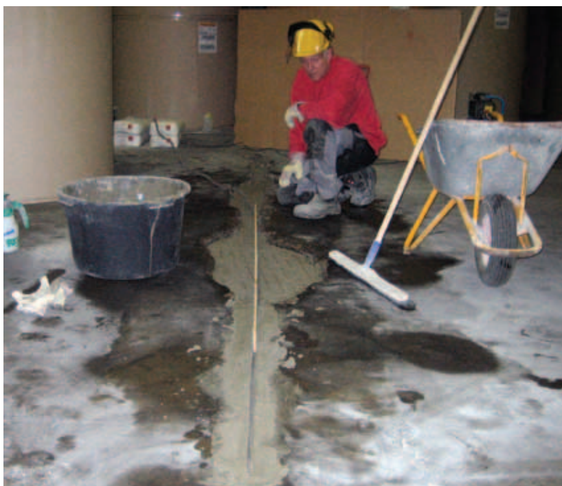
Skadade fogkanter renoverade
