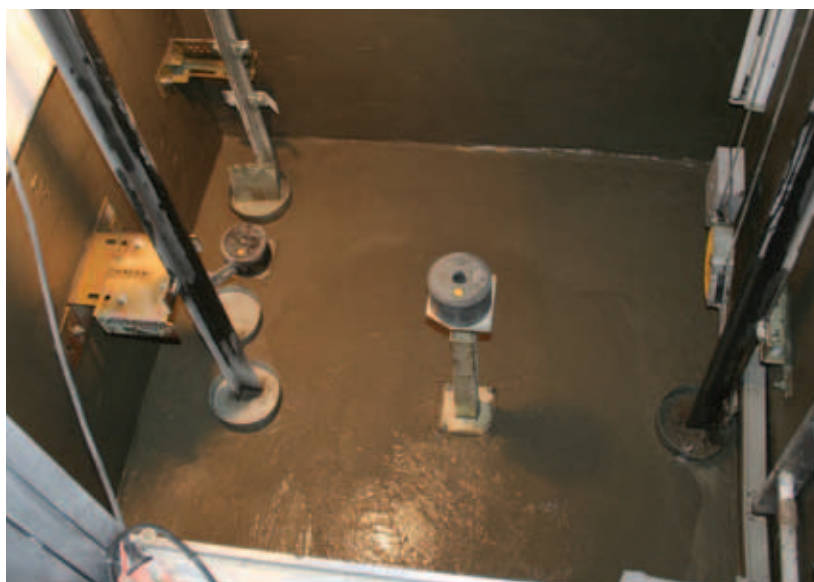
Hisschakt före och efter.
