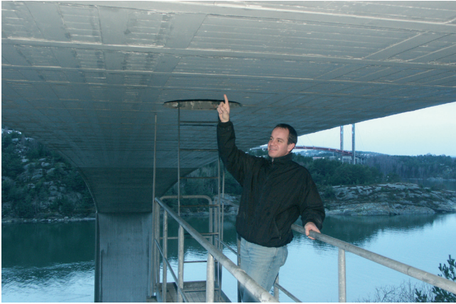
Ulf på SYAB demonstrerar det färdiga resultatet. Idag går det inte att se att Källösundsbron har uppgraderats med fiberförstärkt komposit.
