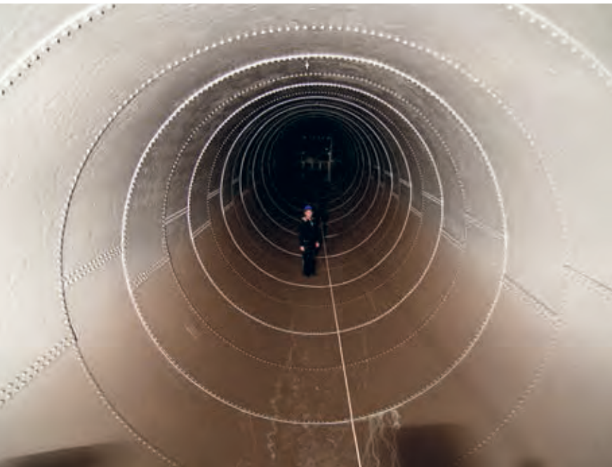
Insidan på en tilloppstub som målats med Interzonesystemet. Värt att notera är att varje nit, skarv etc måste penselappliceras.
