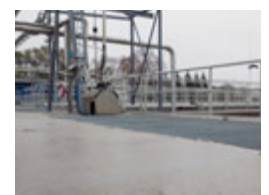
Betong och gångytor är nu klara.
